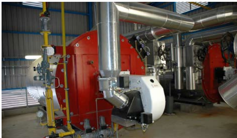
Erst mal anwärmen: der Treibstoff für Seeschiffe wird in solchen Anlagen auf die nötige Betriebstemperatur vorgeheizt
